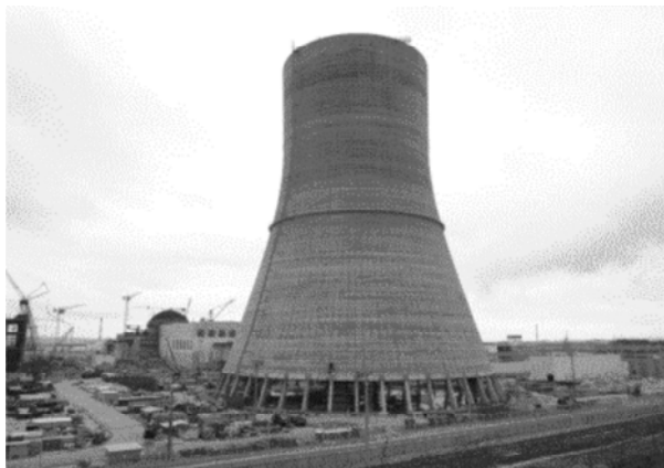
Рисунок 1 - Башенная испарительная градирня блока №3 РАЗС
