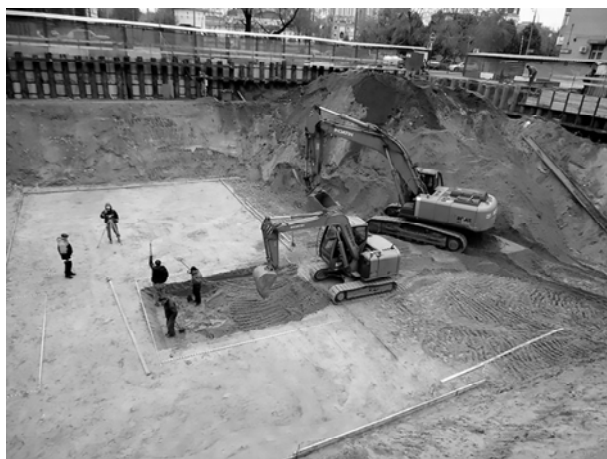
Рис 1. Проведение земляных работ при строительстве котлована
